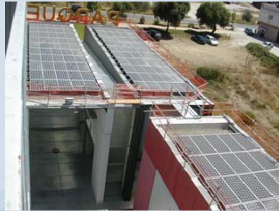
JIMENA DE LA FRONTERA 50 kW
